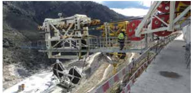
Para potenciar la penetración, los equipos de engrase aplican a presión los lubricantes fluidos de baja viscosidad. Después de un breve periodo de tiempo los lubricantes se densifican, formando una capa grasienta o sólida/elástica alrededor de cada alambre. También se consigue relubricación del alma “el almacén del lubricante”.
